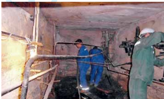
Рис. 4. Полная замена внутридомовых инженерных сетей
