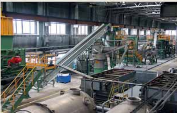
Регрануляционная установка ОАО «Борисовский завод пластмассовых изделий»
