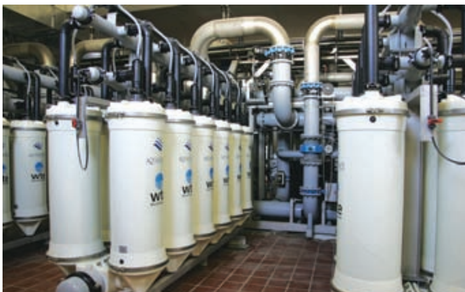
Фото 5. Фильтры с ультрафильтрационными мембранными модулями
