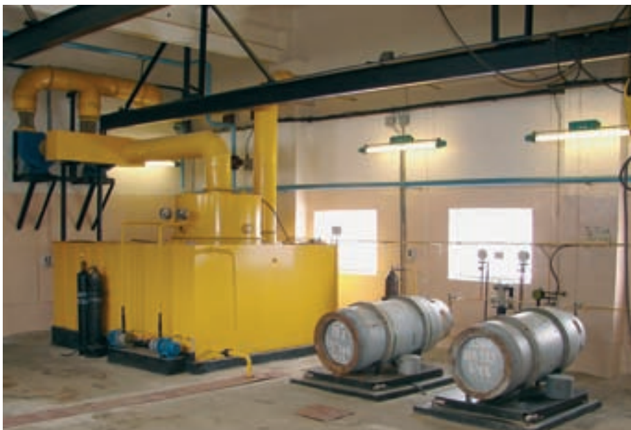
Хлораторная станция на реке Каменушке
