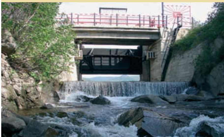
Паводковый водосброс 1-го водохранилища
