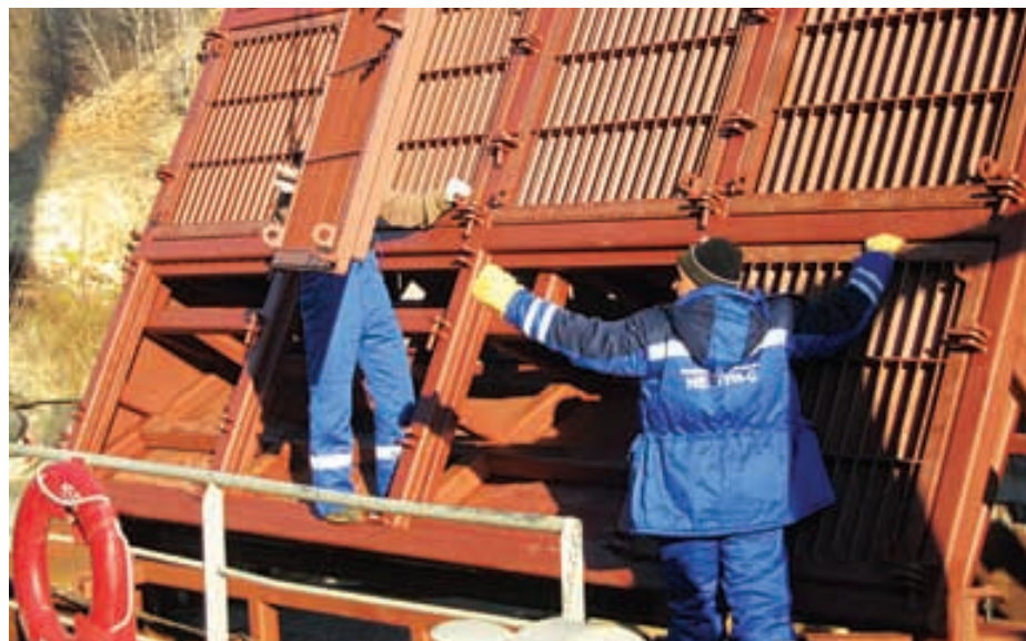
► Монтаж конструкций рыбозащитных сооружений на водозаборный оголовок (НФС-1)
