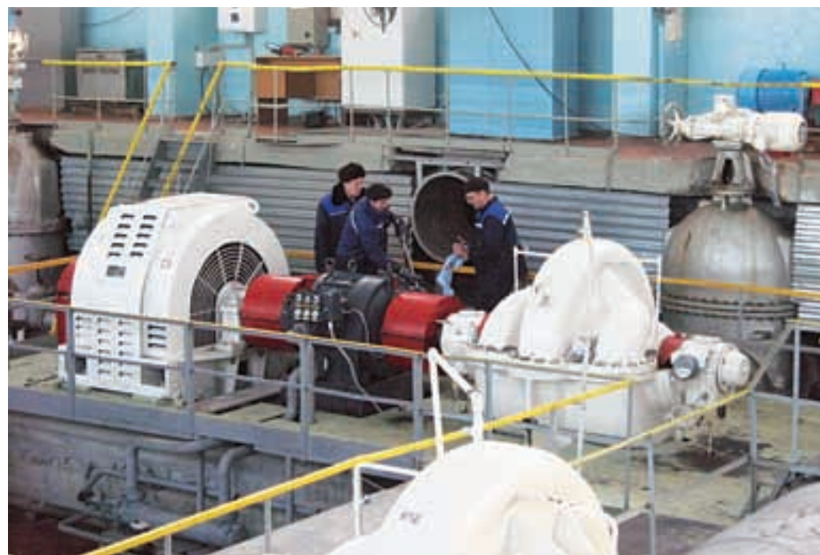
▲ Регламентные работы на комплексе автоматического регулирования давления и расхода воды. Насосная станция второго подъема НФС-1
