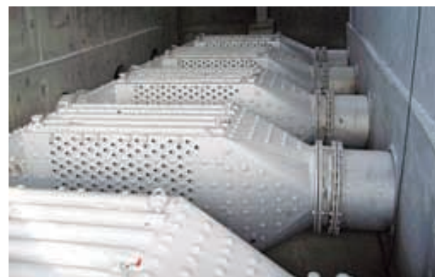
▲ Строящееся сооружение ультрафиолетового обеззараживания (УФО) на НФС-2
