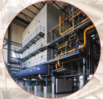
Котлы мощностью от 9,65 до 209МВт типа ПТВМ, КВ-ГМ, КВ-Р/КВ-Ф
