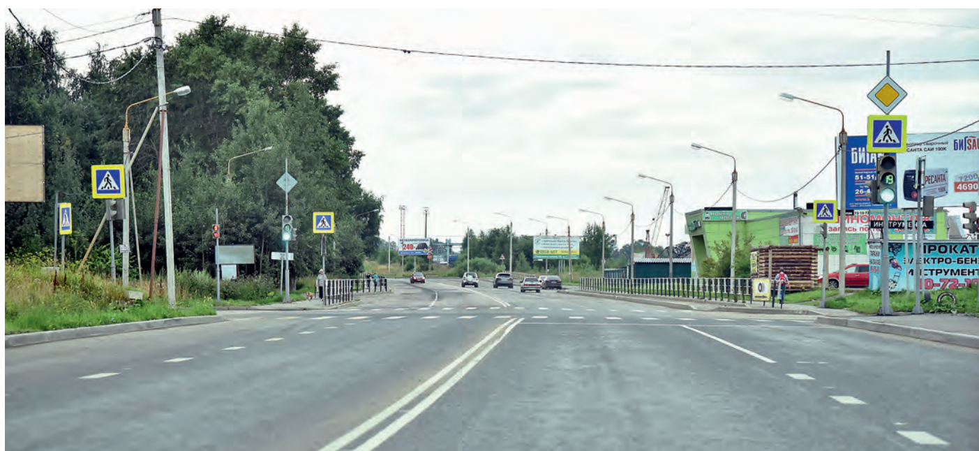
Ул. Преображенского. После ремонта по нацпроекту «Безопасные и качественные автомобильные дороги»
