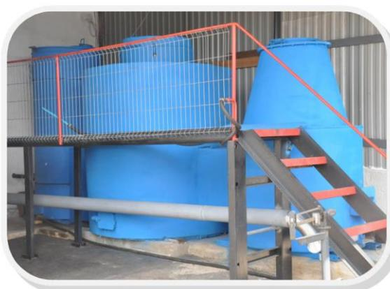
Но если ставить установки в каскад одна за другой то можно получить любую необходимую производительность) и объемом отапливаемого помещения от 750 до 42000 М3.
