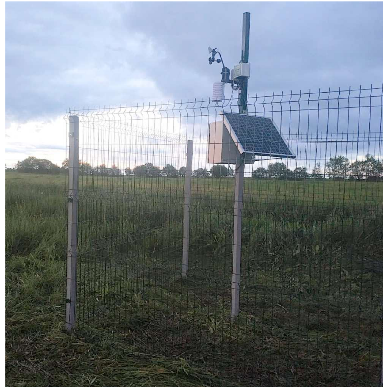
Автономный поста мониторинга с пылемером и газоанализатором Thingenix, анемометром и солнечной панелью
