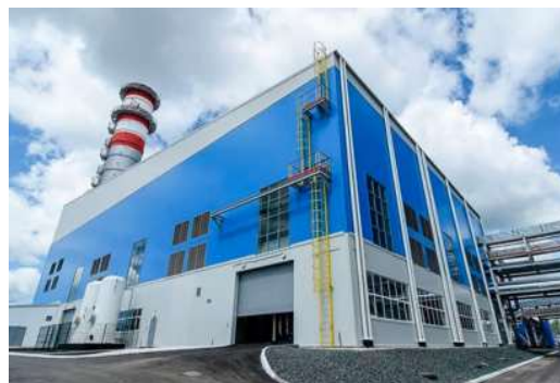
котельные средней мощности до 10-20 МВт
