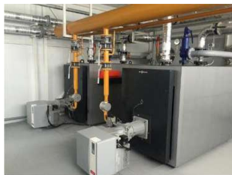
водогрейные котлы Rossen/Viessmann и др. до 700 кВт-2 МВт
