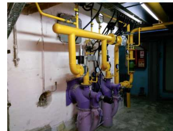
Паровой котел ДКВР 20. Завод Силикатного кирпича г. Саратов
